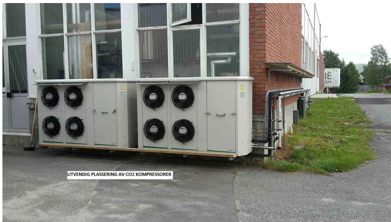
CO 2 -kompressorer ved Rørosmeieriet. Foto: Ola Hilmarsen
